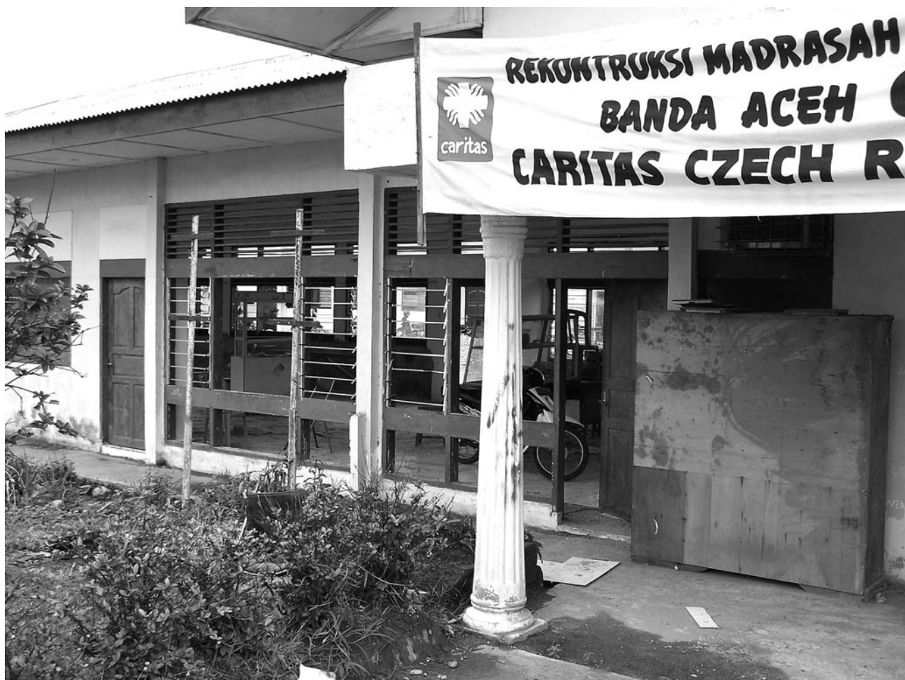
Střední škola MANN 2 před rekonstrukcí, Banda Ach
